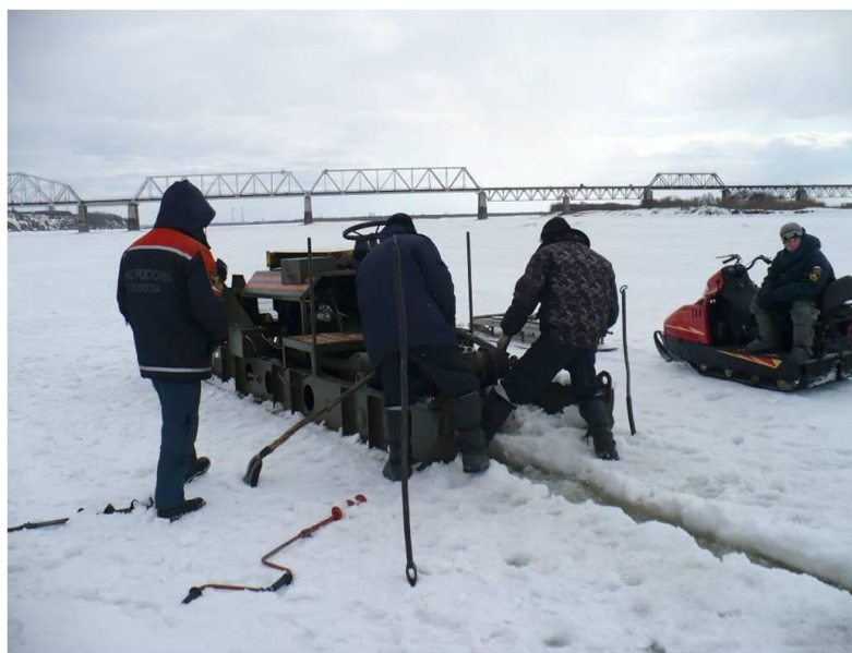
Рисунок 1. Проведение ледорезных работ
